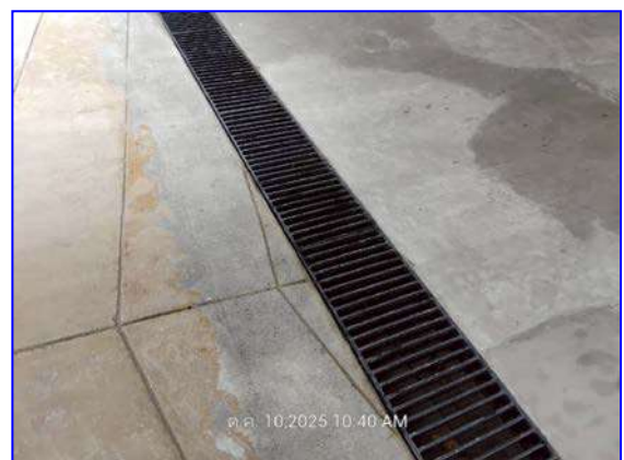
รูปที่ 2.11 รางระบายน้ำ พร้อมตะแกรงดักขยะ
