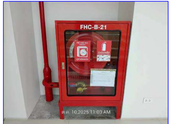
รูปที่ 2.29 ถังดับเพลิง และตู้เก็บสายฉีดน้ำดับเพลิง
