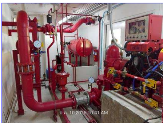
รูปที่ 2.34 ระบบ Fire Pump
