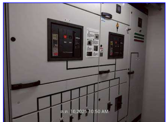
รูปที่ 2.19 ตู้ MDB Main Distribution Board
