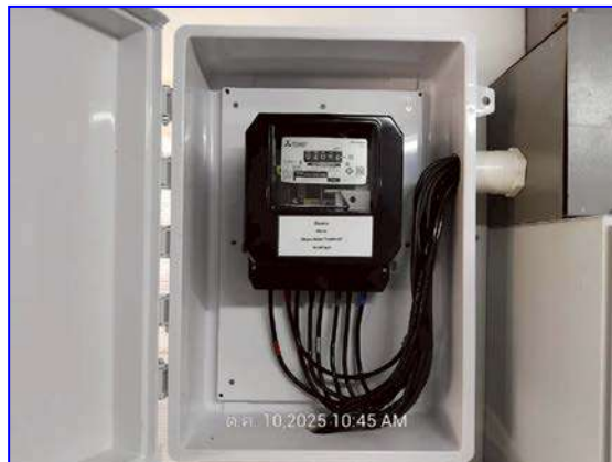
รูปที่ 2.13 มิเตอร์ระบบบำบัดน้ำเสีย
