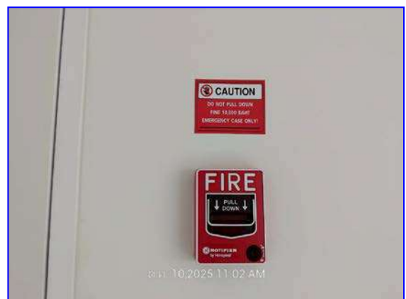
รูปที่ 2.31 สัญญาณแจ้งเตือนเหตุเพลิงไหม้
