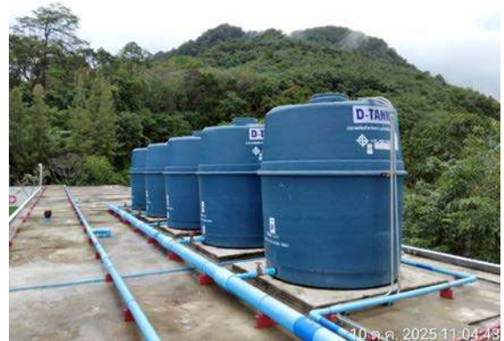
รูปที่ 2.15 ถังเก็บน้ำใต้ดินและชั้นดาดฟ้า
