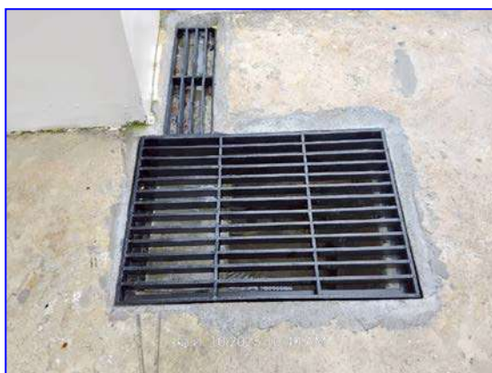
รูปที่ 2.11 รางระบายน้ำ พร้อมตะแกรงดักขยะ
