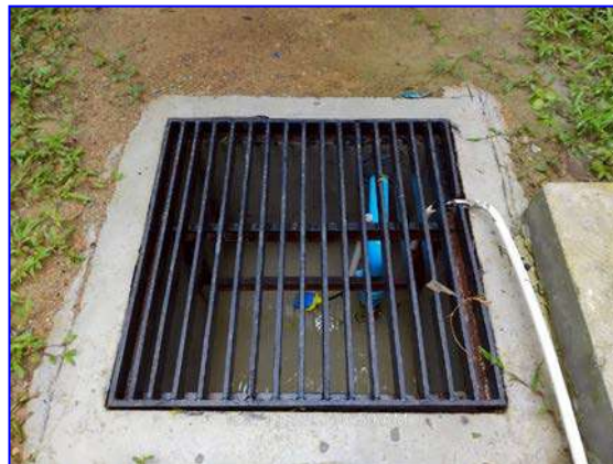
รูปที่ 2.16 บ่อหนองน้ำ และปั๊มสูบน้ำ
